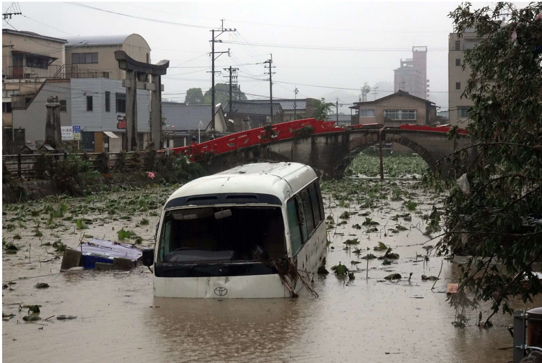
国宝青井阿蘇神社の蓮池と御祓橋の被災状況
